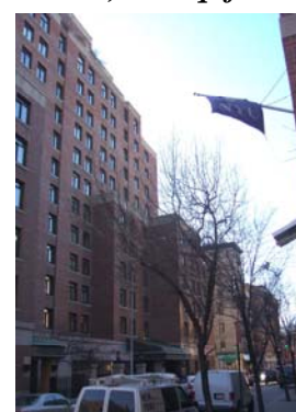
D'Agostino Hall (1986) 110 West 3 rd Street
